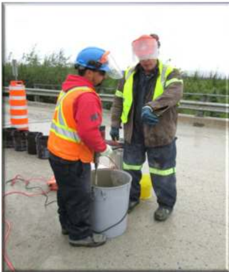
🧑‍🔧 Préparation du coulis de réparation
