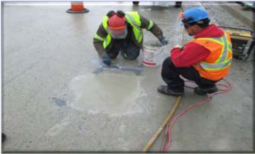
🧱 Réparation de la dalle à 0.25L
