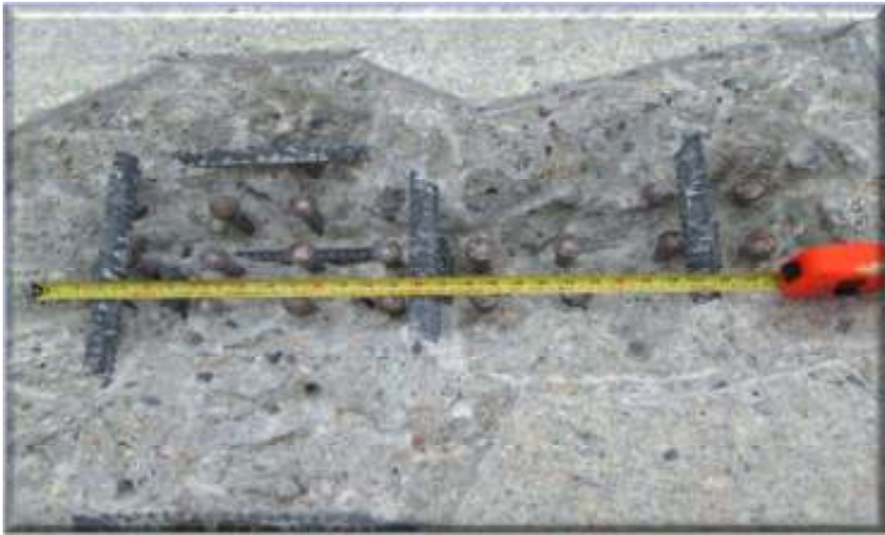
🧱 Démolition de la dalle près de l'appui
