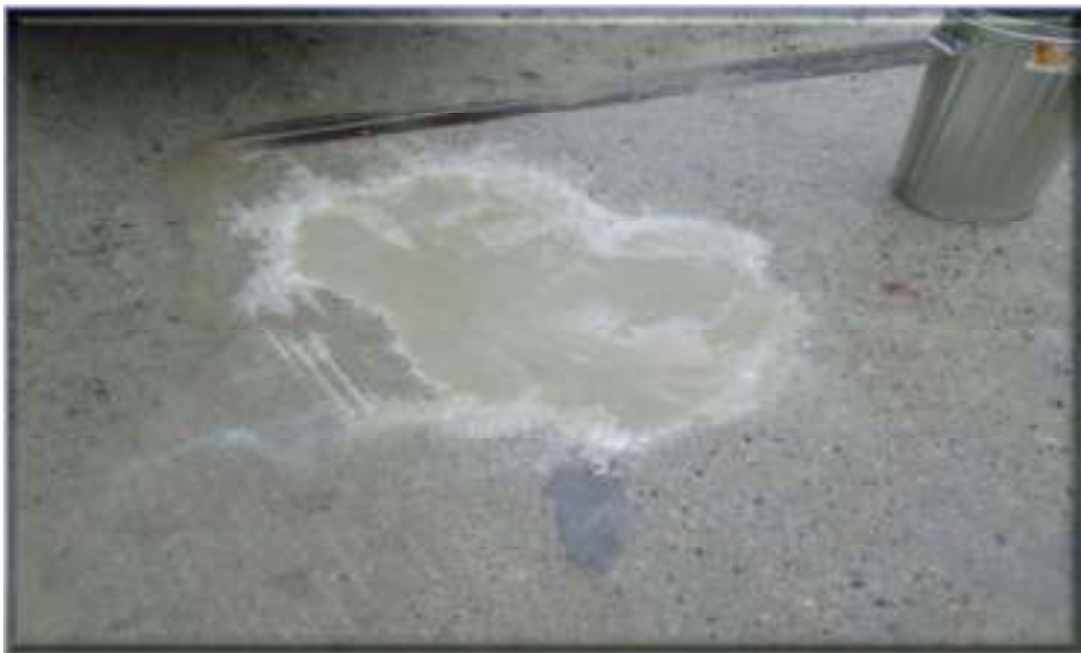
🧱 Réparation de la dalle près de l'appui
