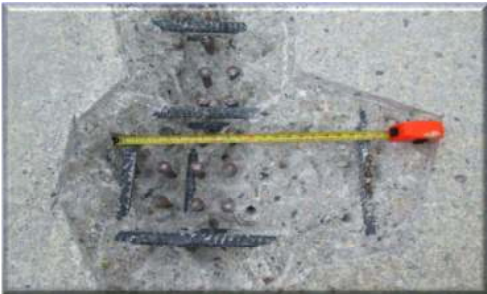
🏗️ Démolition de la dalle près de l'appui
