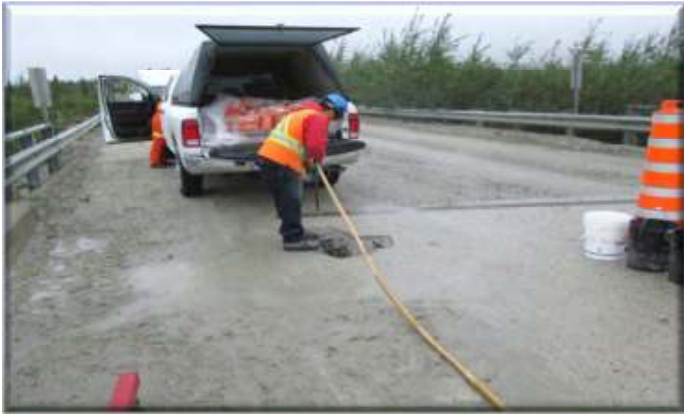
🧑‍🔧 Travaux de nettoyage du béton avant le bétonnage
