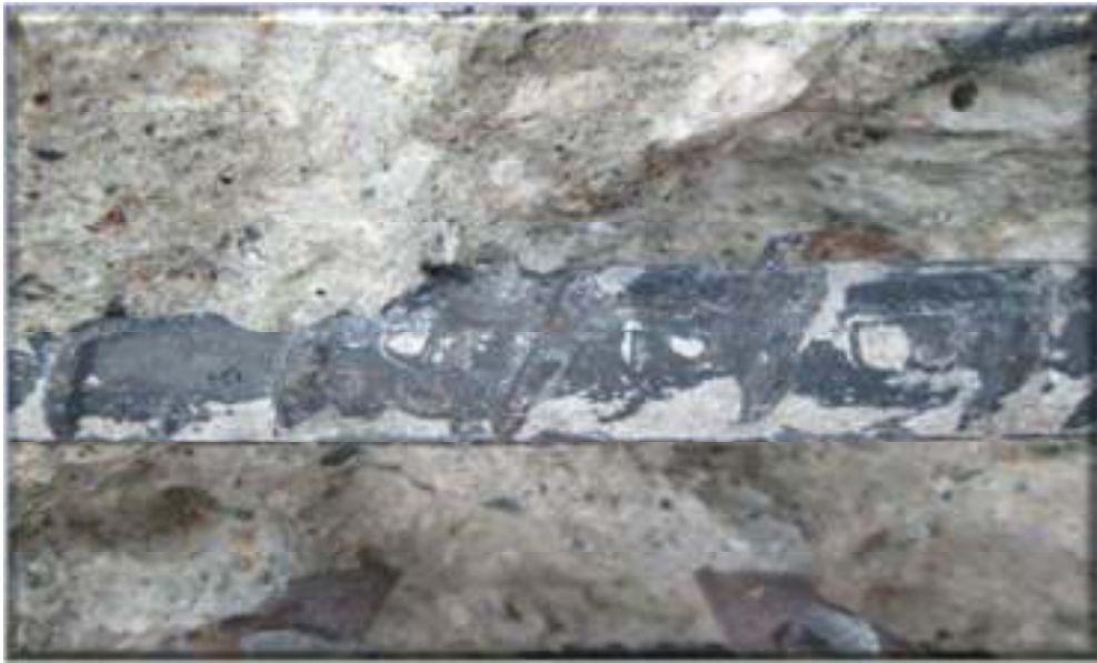
🧱 Détail d'une barre d'armature transversale (B25)
