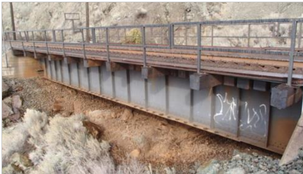
Figure 8.5-68 : Exemple de pont PPT
