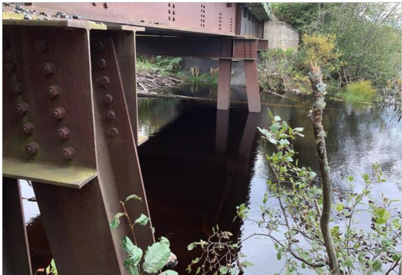
Figure 8.5-74 : Vue générale du pont au PK 167.59
