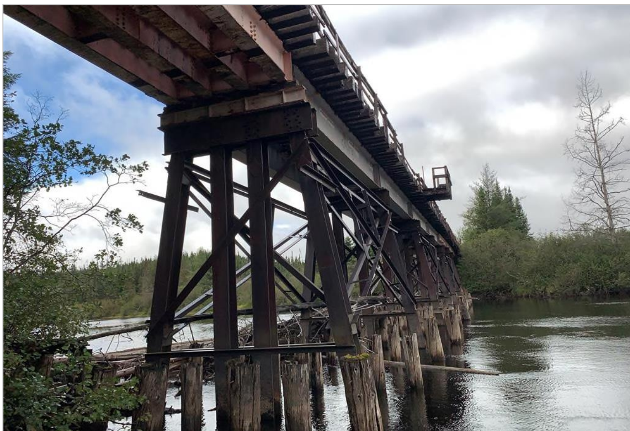
Figure 8.5-80 : Vue générale du pont au PK 156.00
