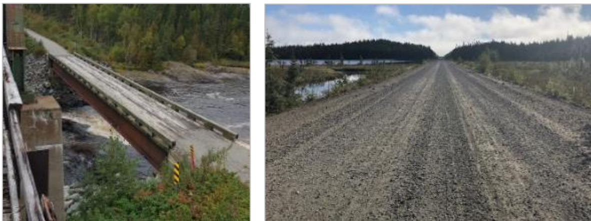
Figure 8.9-6 : Photos du site du pont et de la route par VEI
