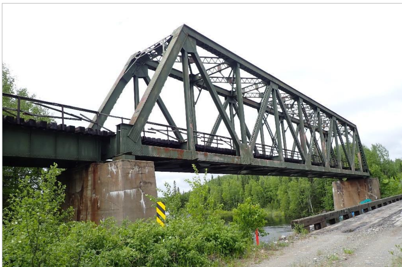
Figure 8.5-78 : Vue générale du pont au PK 201.72
