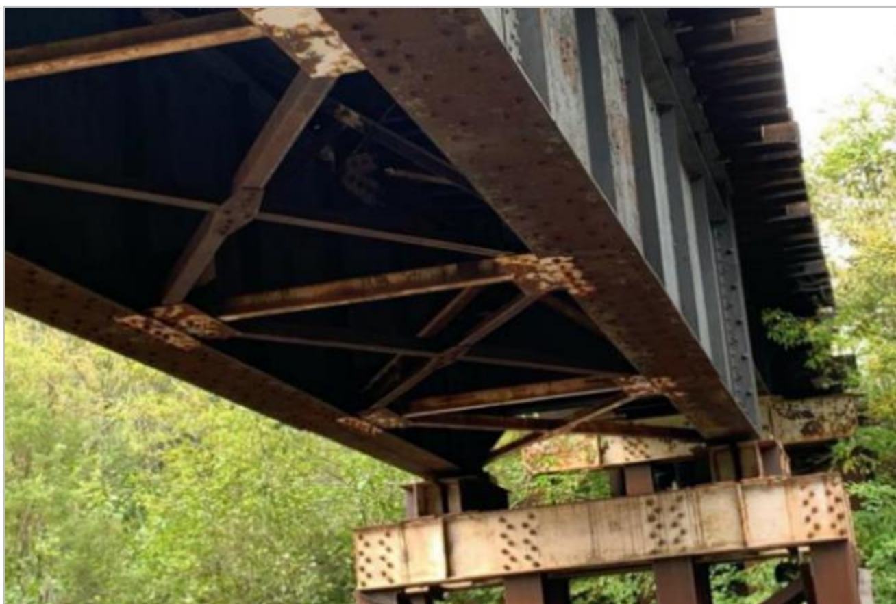
Figure 8.5-73: Vue générale du pont au PK 163.85
