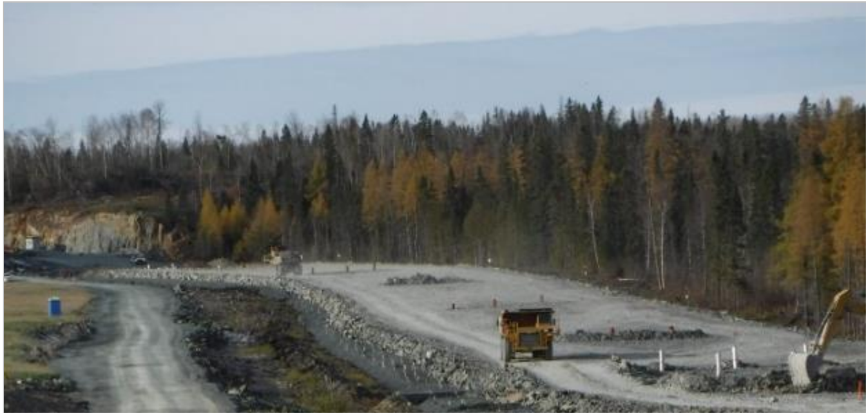
Figure 8.5-23 : Mise en place des remblais lors de la construction d'une plateforme
