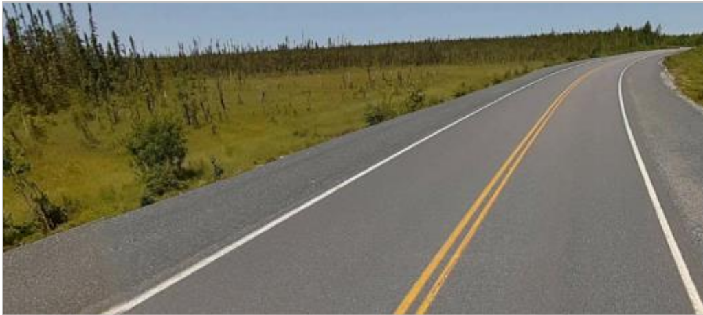
Figure 8.5-39 : Passage d'une zone humide (PK 197+400; la voie ferrée sera à 30 m sur la gauche)
