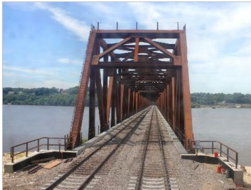
Figure 8.5-70 : Exemple de pont PPT
