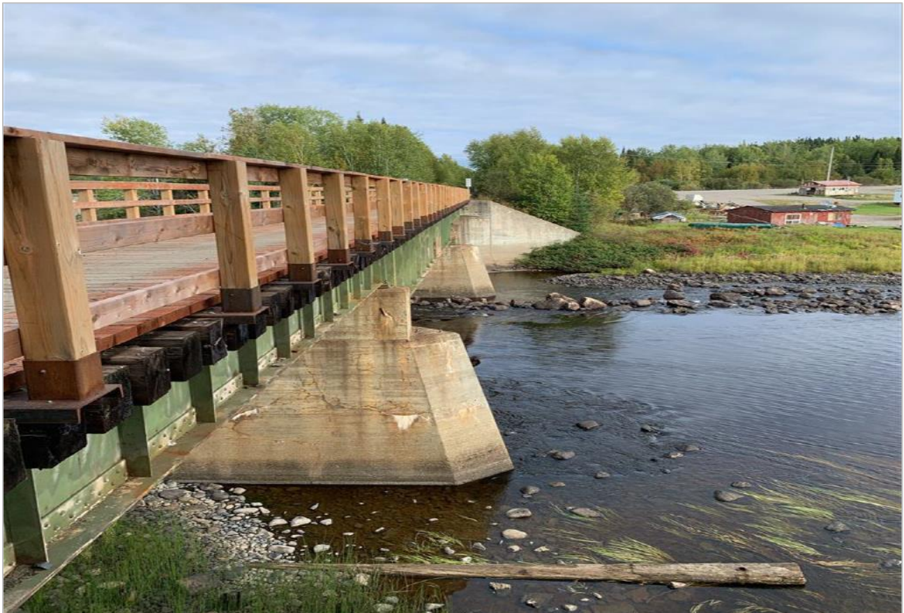
Figure 8.5-72 : Vue générale du pont au PK 146.50
