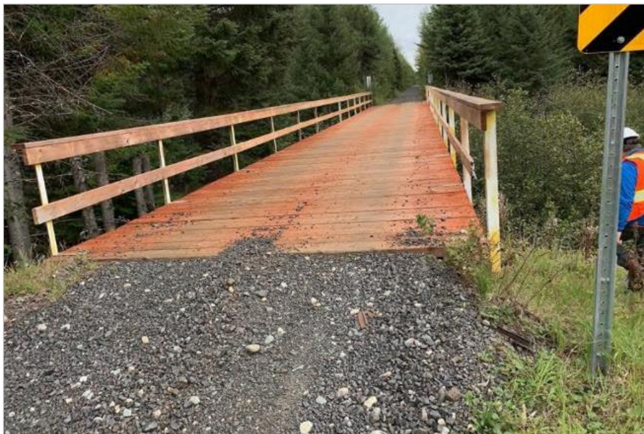
Figure 8.5-75 : Vue générale du pont au PK 169.95
