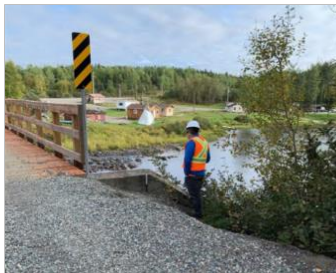
Figure 8.5-71 : Inspection du pont de la rivière O'Sullivan
