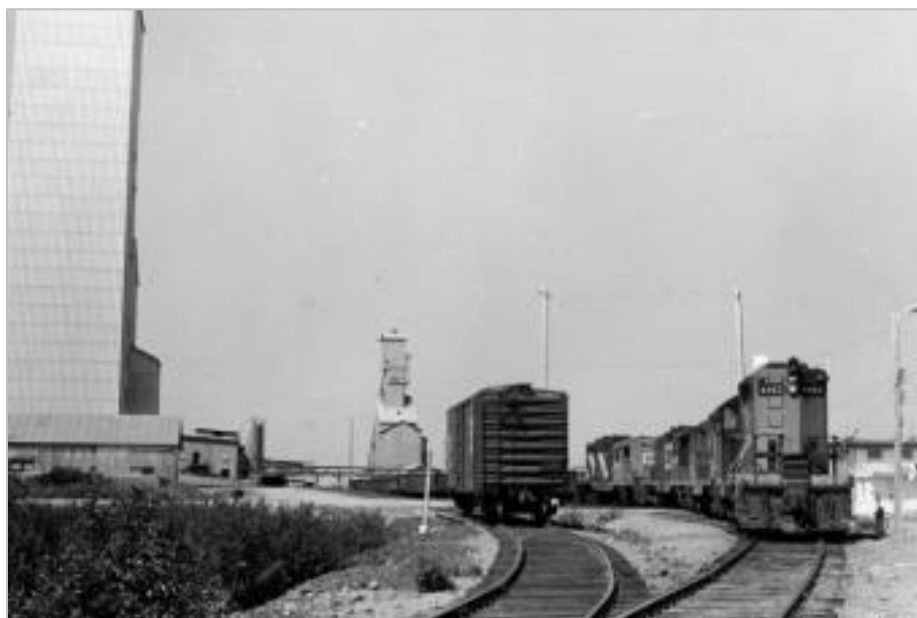
Figure 8.5-2 : Train de marchandises du CN chargeant du concentré de minerai à la mine de Chapais, 1976
