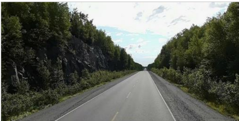
Figure 8.5-38 : Zone rocheuse (PK 16+040; la voie ferrée sera à 60 m sur la gauche)
