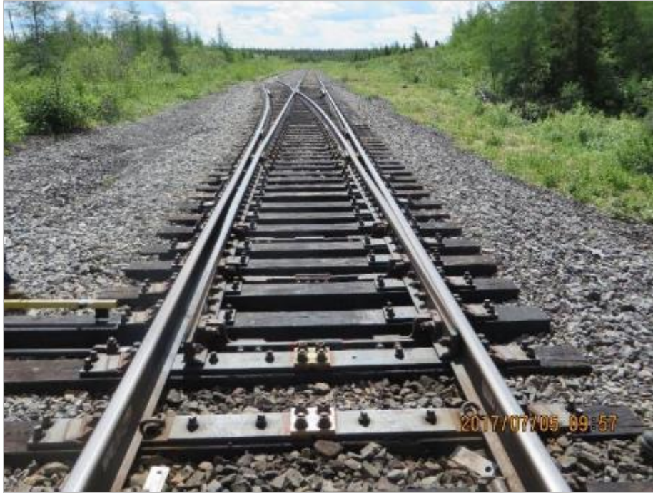
Figure 8.5-31 : Photo d'un aiguillage typique n° 8
