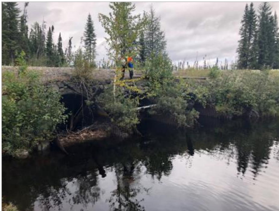
Figure 8.5-98 : Ponceaux en TTO existants de 3 \times 2\ 400 mm traversant la plateforme Grevet-Chapais au PK 229.2
