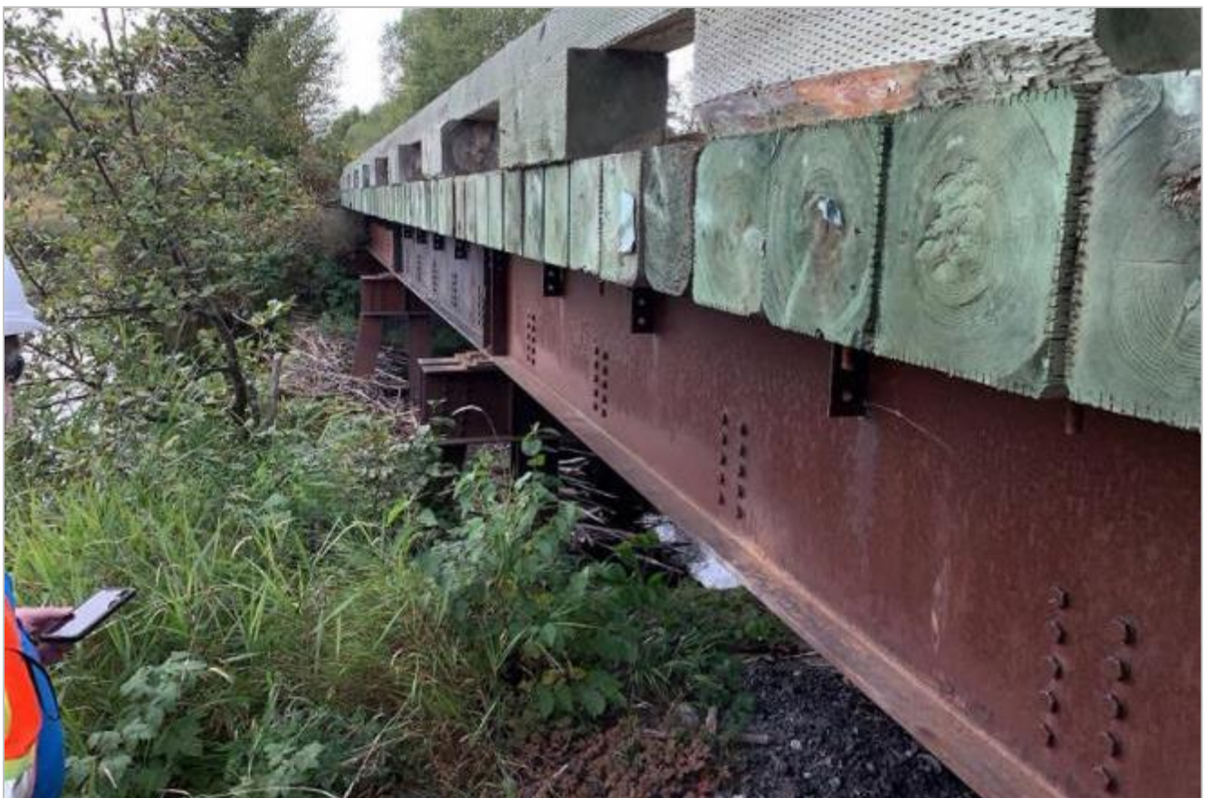
Figure 8.5-76 : Vue générale du pont au PK 191.15
