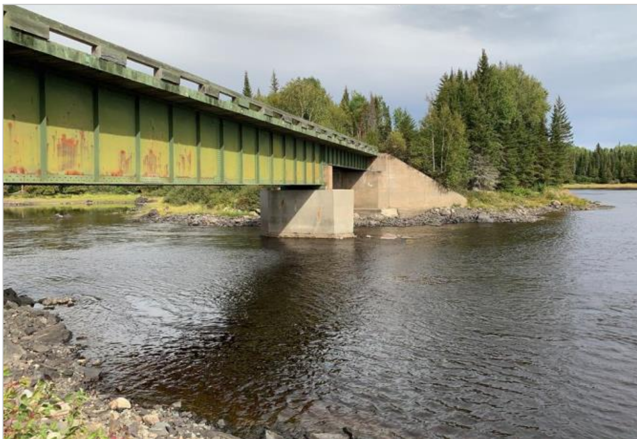
Figure 8.5-77 : Vue générale du pont au PK 196.86
