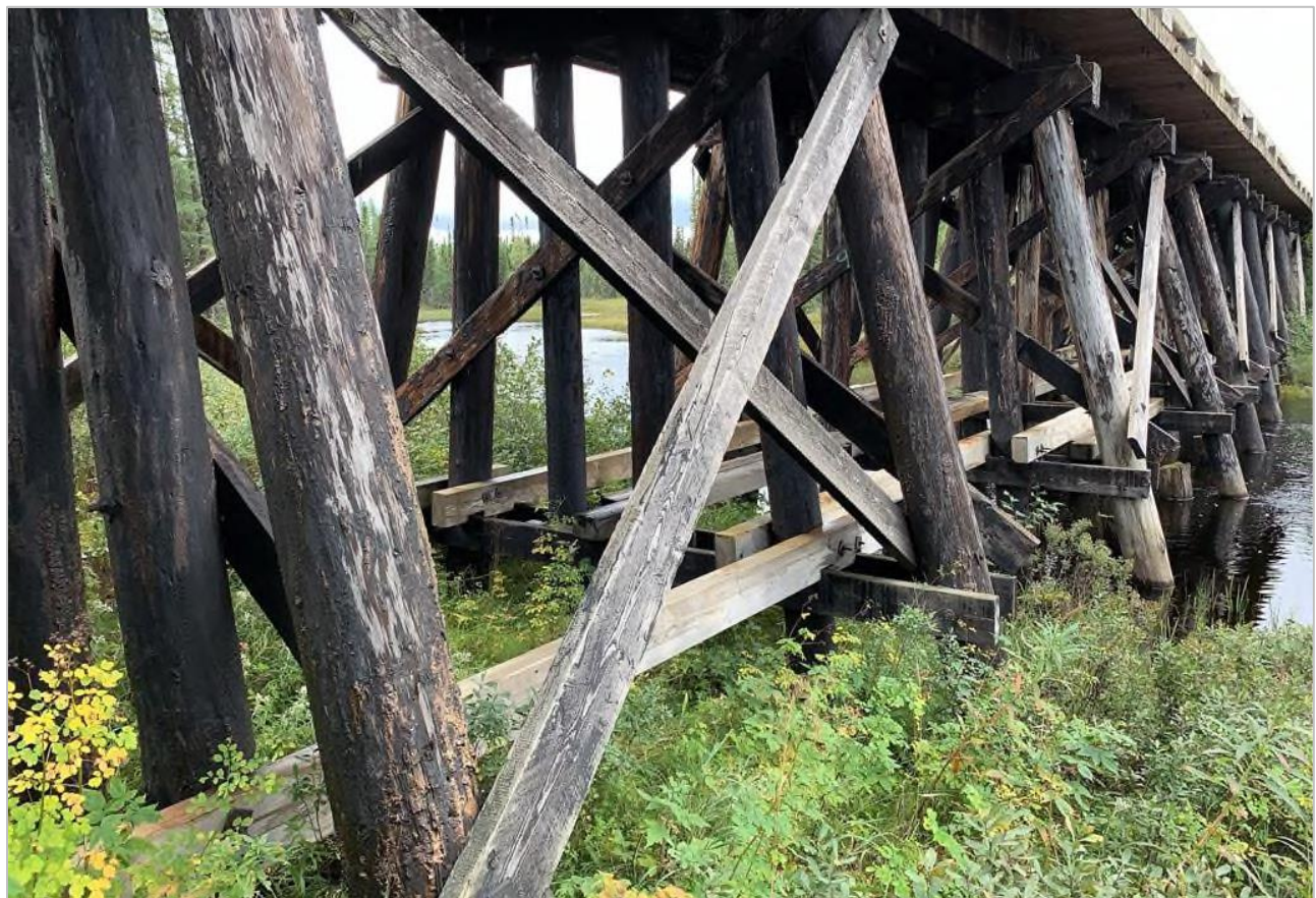
Figure 8.5-79 : Vue générale du pont au PK 236.71
