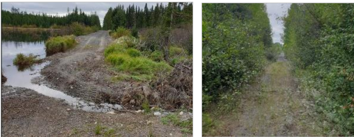
Figure 8.5-34 : Exemples de l'érosion et de l'empiètement de la forêt sur le sentier du lotissement Chapais
