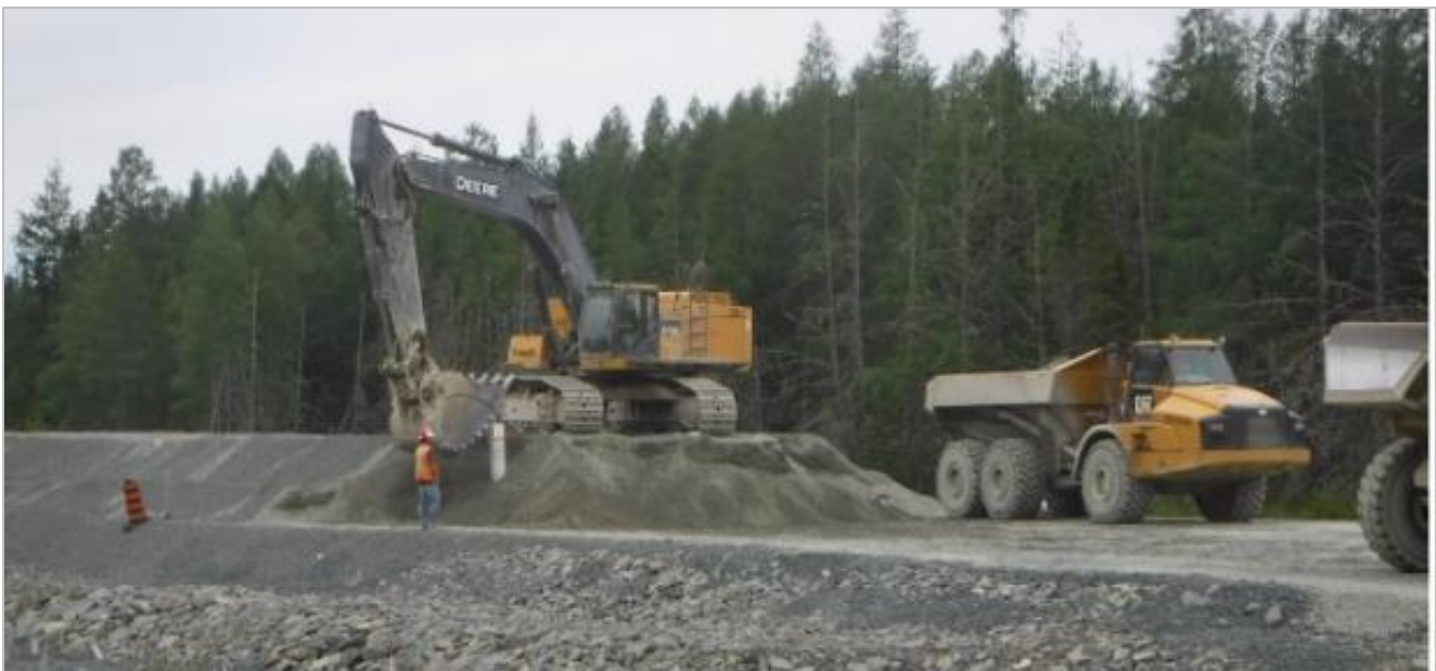
Figure 8.5-27 : Enlèvement du matériau de surcharge granulaire; manuel sur les sols compressibles
