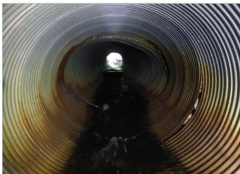
Figure 8.7-9 : Ponceau inspecté sur la Route du Nord
