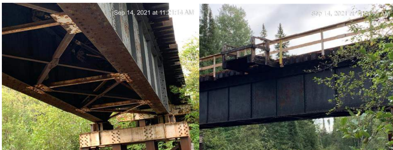
Figure 3-1 : Vues générales du pont PM 101.80
