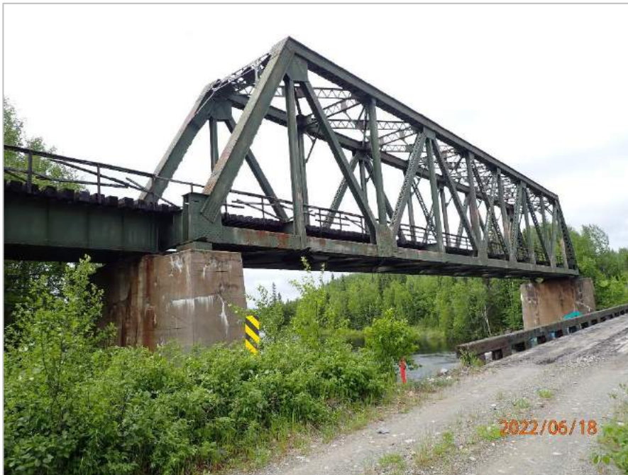
Figure 3-1 : Vues générales du pont PM 125.30
