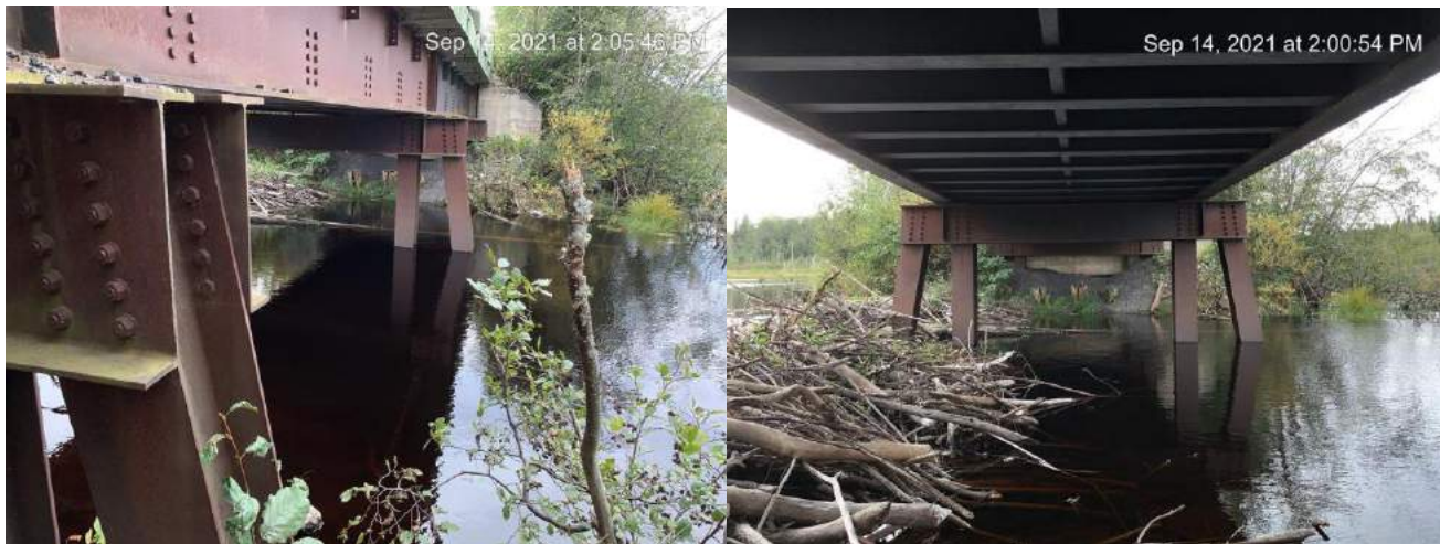
Figure 3-1 : Vues générales du pont PM 118.80
