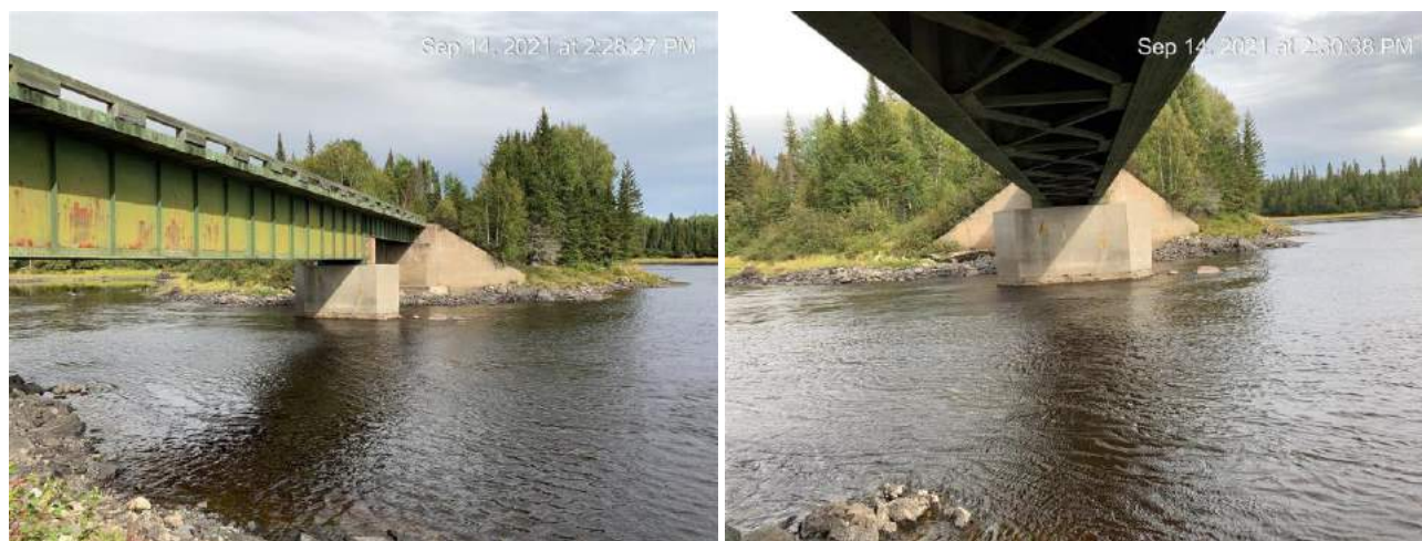
Figure 3-1 : Vues générales du pont PM 122.30
