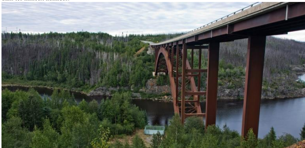
Figure 3-1 Pont routier existant au-dessus de la rivière Eastmain
