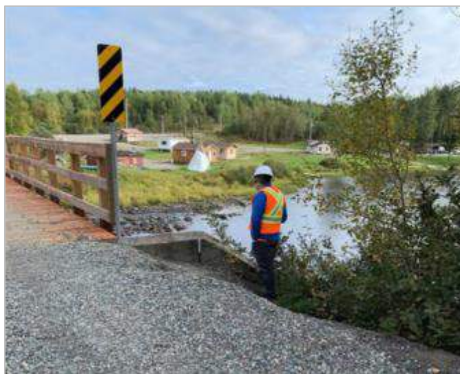
Figure 8.5-71 : Inspection du pont de la rivière O'Sullivan
