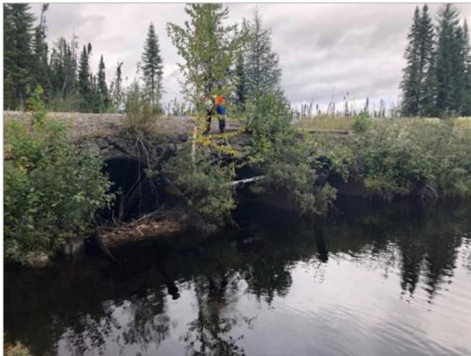
Figure 8.5-98 : Ponceaux en TTO existants de 3 x 2 400 mm traversant la plateforme Grevet-Chapais au PK 229.2
