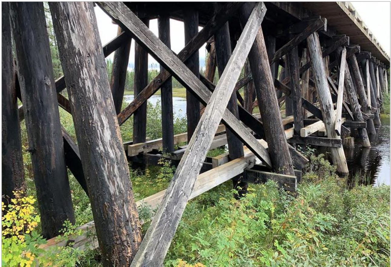
Figure 8.5-79 : Vue générale du pont au PK 236.71
