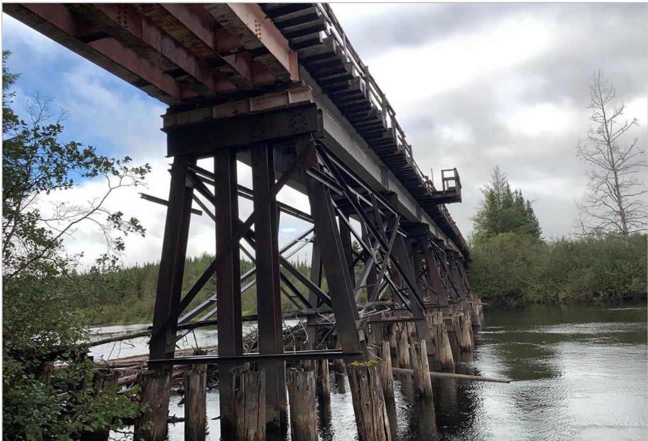
Figure 8.5-80 : Vue générale du pont au PK 156.00
