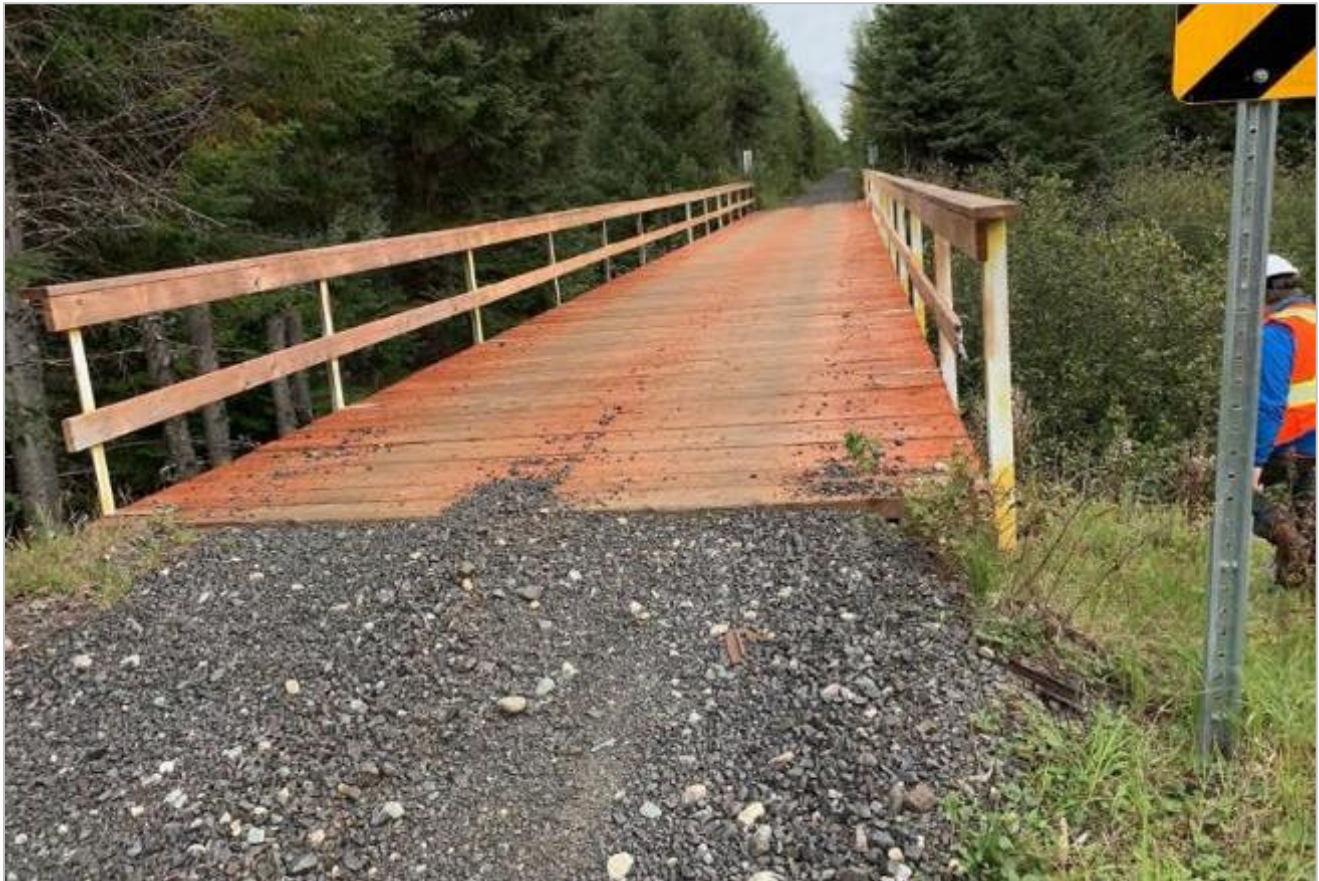
Figure 8.5-75 : Vue générale du pont au PK 169.95
