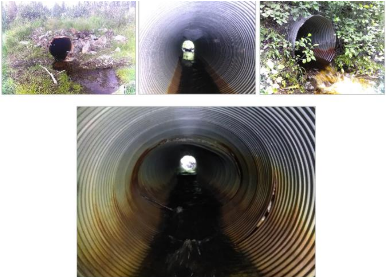
Figure 8.7-9 : Ponceau inspecté sur la Route du Nord
