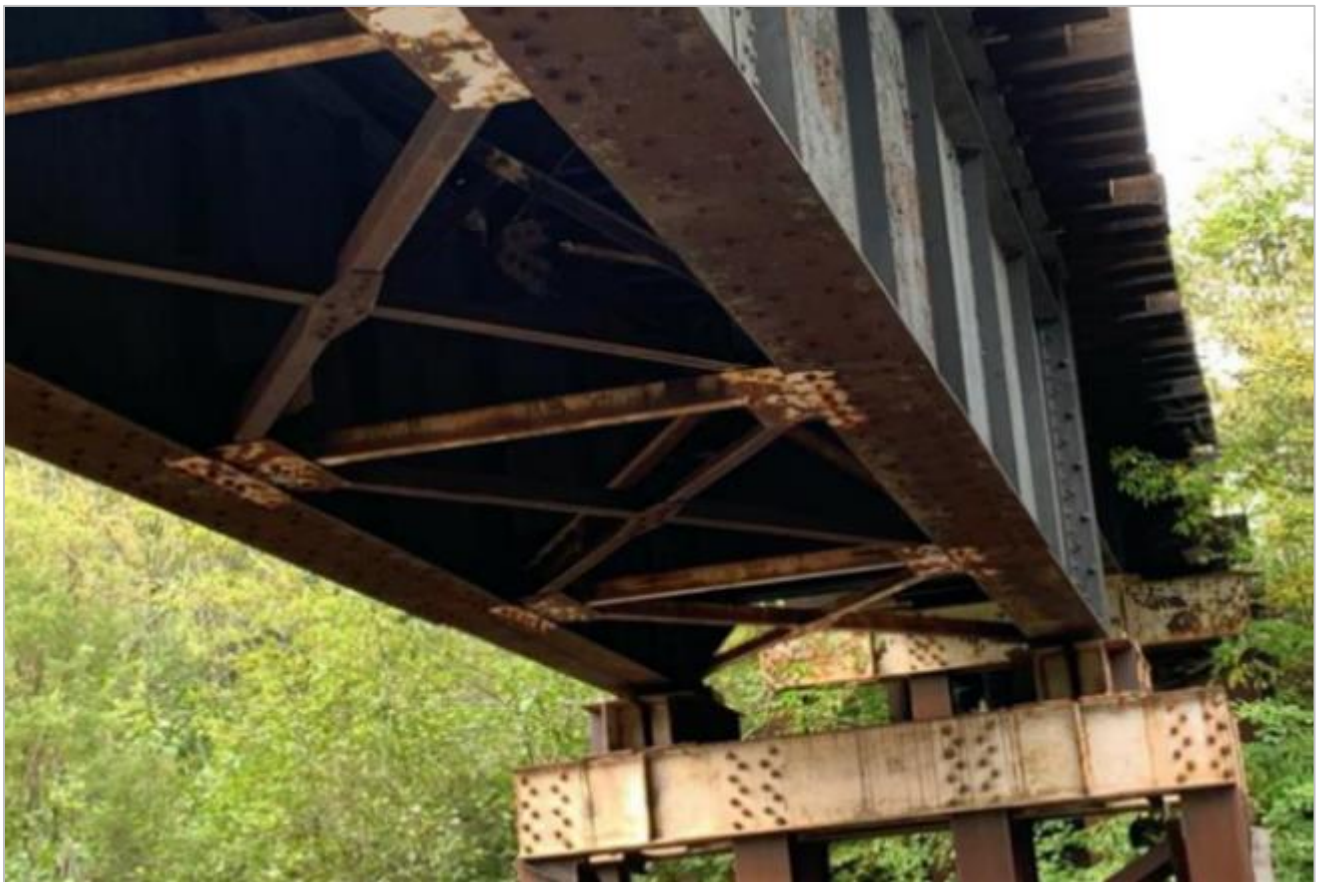
Figure 8.5-73: Vue générale du pont au PK 163.85
