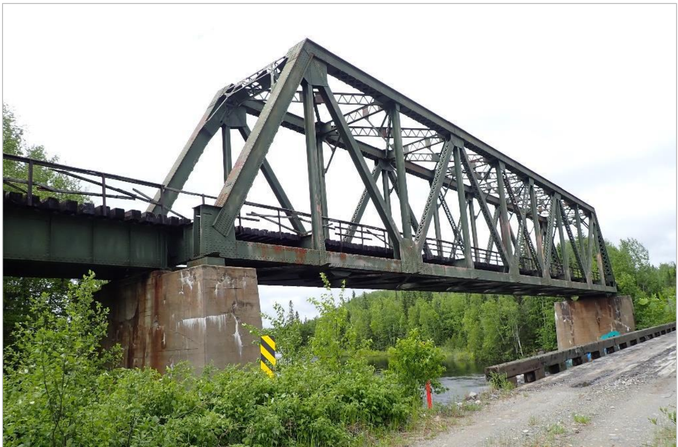
Figure 8.5-78 : Vue générale du pont au PK 201.72
