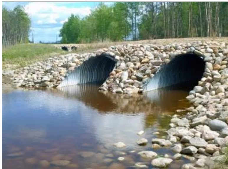
Figure 8.5-92 : Exemple d'un ponceau en TTO
