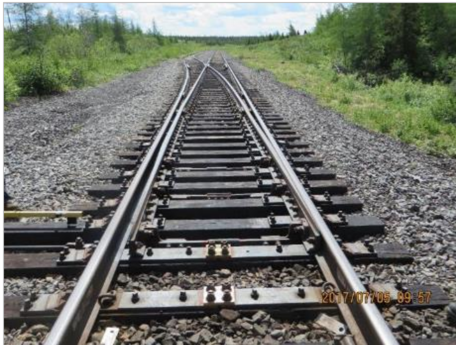
Figure 8.5-31 : Photo d'un aiguillage typique n° 8
