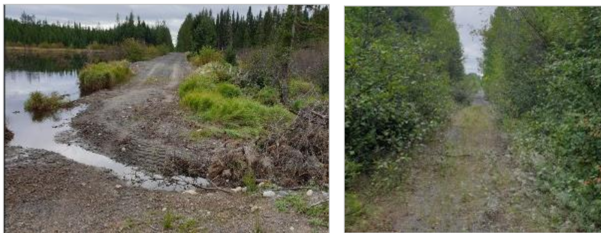
Figure 8.5-34 : Exemples de l'érosion et de l'empiétement de la forêt sur le sentier du lotissement Chapais
