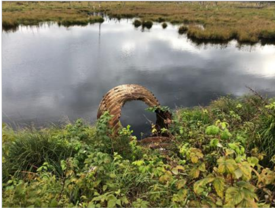
Figure 8.5-97 : Ponceau en TTO existant de \pm 1\ 500 mm de diamètre traversant la plateforme Grevet-Chapais au PK 220.1 (Le ponceau est rouillé et brisé)
