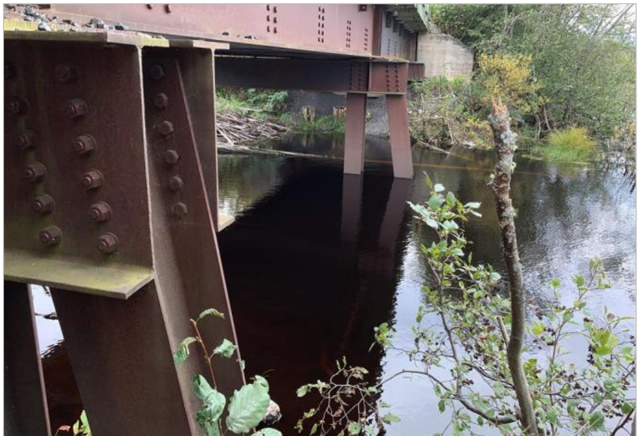
Figure 8.5-74 : Vue générale du pont au PK 167.59
