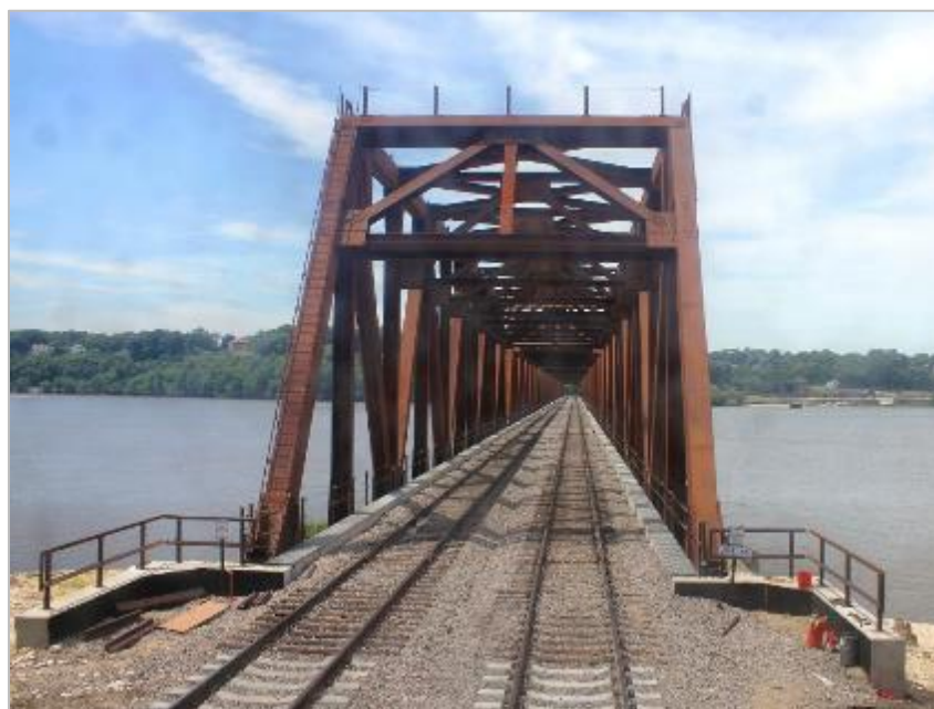
Figure 8.5-70 : Exemple de pont PPT
