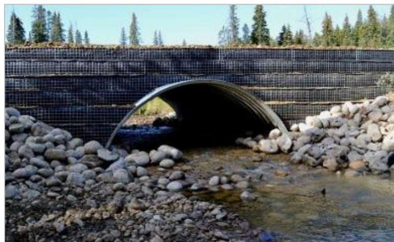
Figure 8.5-93 : Exemple de ponceau en arc à plaque d'acier sans fond
