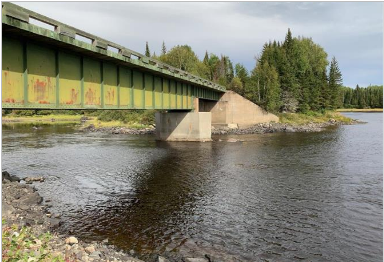
Figure 8.5-77 : Vue générale du pont au PK 196.86
